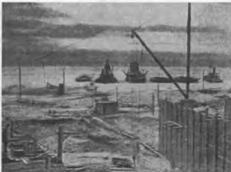
Выемка в земле и сруб из бревен — на такие простые складываемые разлагал тов. Френкель работу по созданию камеры шлюзов
