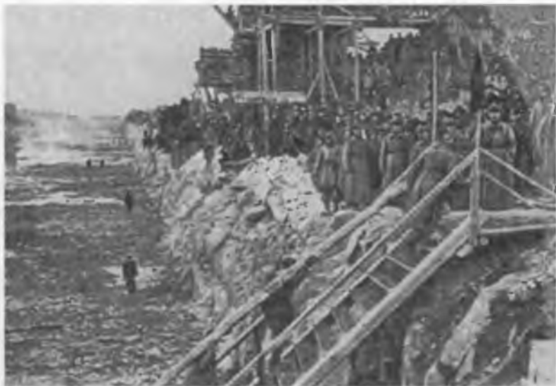
Выемка готова, но зачистка еще не произведена
