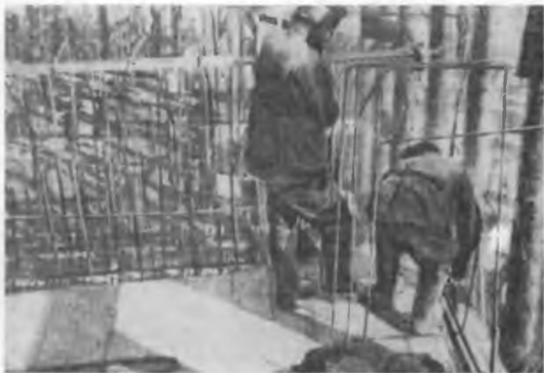
Работа арматурищиков: железо в конструкции примет на себя усилия растяжения, бетон — сжатия
