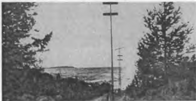
Здесь будет канал. Отметки на столбах показывают будущий уровень воды в канале
