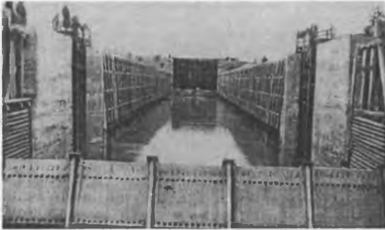
В шлюзе поднят ремонтный затвор
