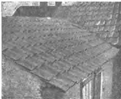
Покрытіе желобчатую черепицею.
