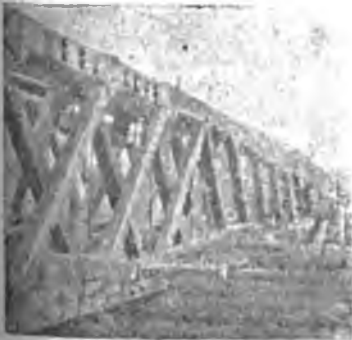
Сборка ферм Гау сь подмостей (подъ шоссевую дорогу).
