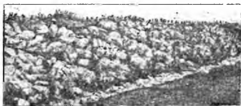
Плетневые кѣтки съ набрскою камня по откосу дамбы.
