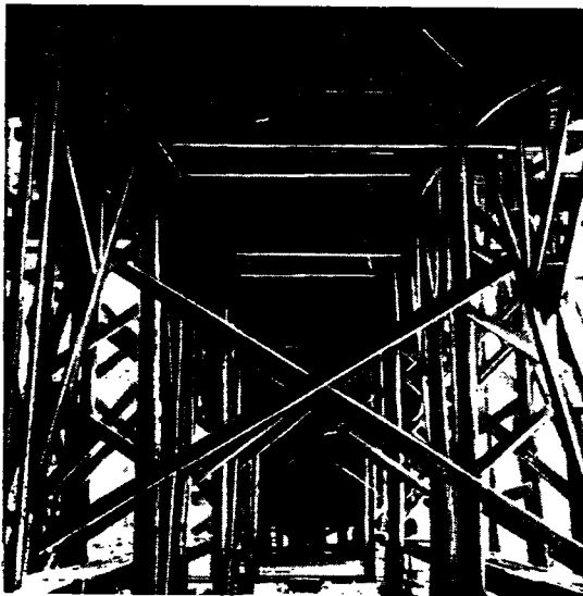
Фиг. 23. Опорные рамы (связанные престоми) при испытании ферм фиг. 5
