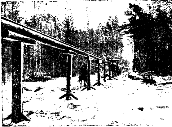
Фиг. 18. Однорельсовая подвесная железная дорога жесткого типа системы Диканского
