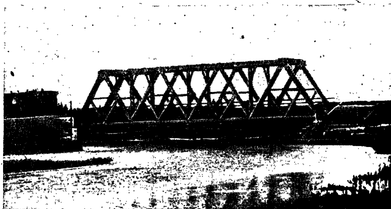
Фиг. 4. Деревянный мост системы инж. Квятковского пролетом 45 м под однупутную железную дорогу
