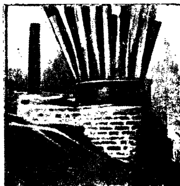
Фиг. 3. Простейшая установка для пропитки по способу горяче-холодной ванны
