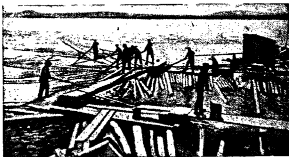
Фиг. 25. Доставка плиток самоплавом или буксиром к горлу береговой запани
