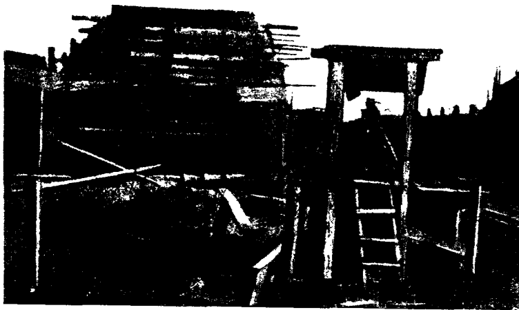
Фиг. 24. Теодолит и горизонтальные рейки для контроля высоты фермы
