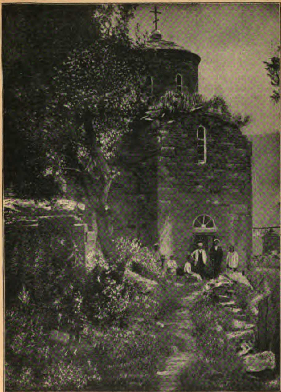
№ 20.—Сентинскій храмъ. Видъ съ западной стороны.
