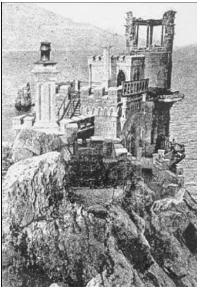
Знаменитое «Ласточкино гнездо» после сентябрьского землетрясения. Башня разрушена, видны трещины в скале.
