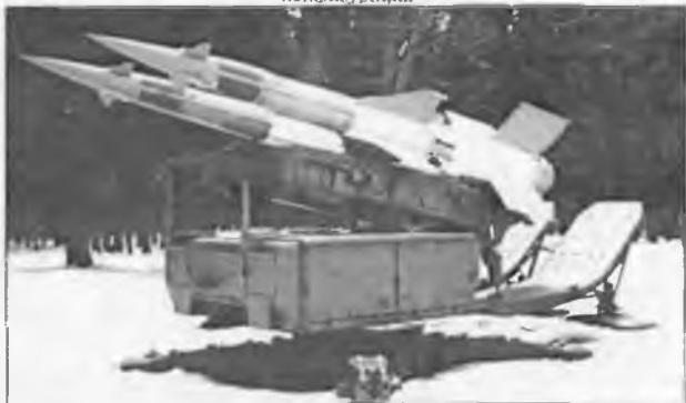
Габаритно-весовые макеты ракет 5В27 на двухбалочной пусковой установке 5П71 ЗПК С-125 "Нева"
