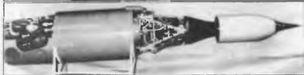
Опытный гиперзвуковой прямоточный двигатель, созданный по программе "Холод"
