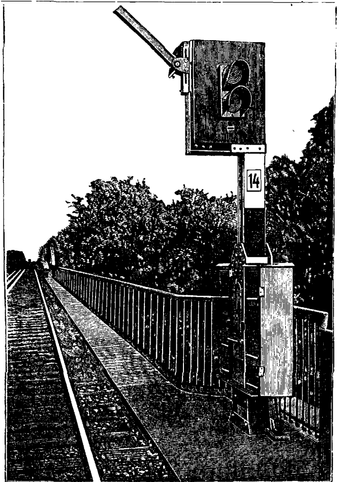
Фиг. 1. Путьевой семафор для механич. А. п.
