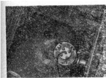
Рис. 30. Электролизер ионатора „Сита-Сина“, установленный в резервуаре с чистой водой.
