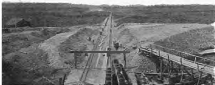
Подача руды въ вагонеткахъ изъ рудниковъ на заводъ.
