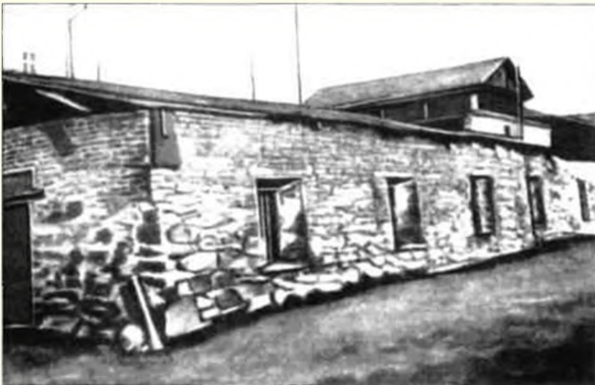
Заводская тюрьма для рабочих завода Демидовых
