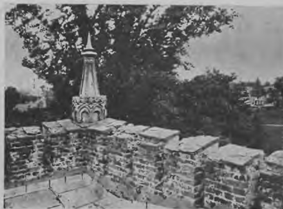
Zamek w Rzemieniu. Fragment szczytu przed przebudową
