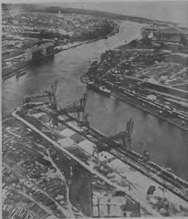
Gdańsk. Wisłoujście. Basen dla towarów masowych
