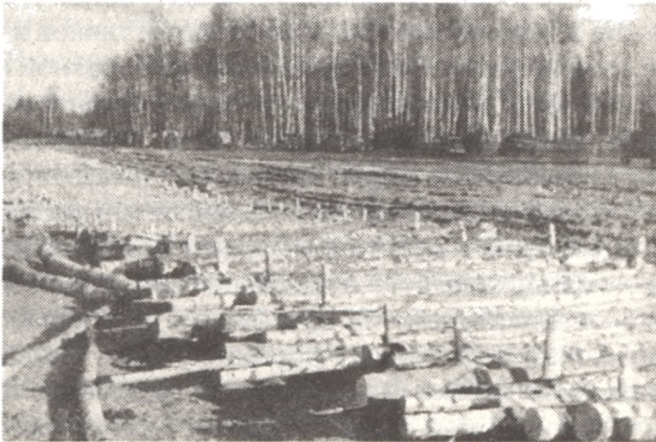
«Автобан» по-русски. Для обеспечения снабжения войск в октябре 1941 г. немцами была построена гигантская гать из 35 тыс. деревьев.
