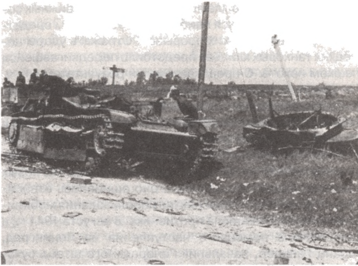
Разрушенный взрывом боекомплект танк Т-28. Взрывом были сорваны все три башни. Орудийная башня лежит перевернутой рядом с танком.
