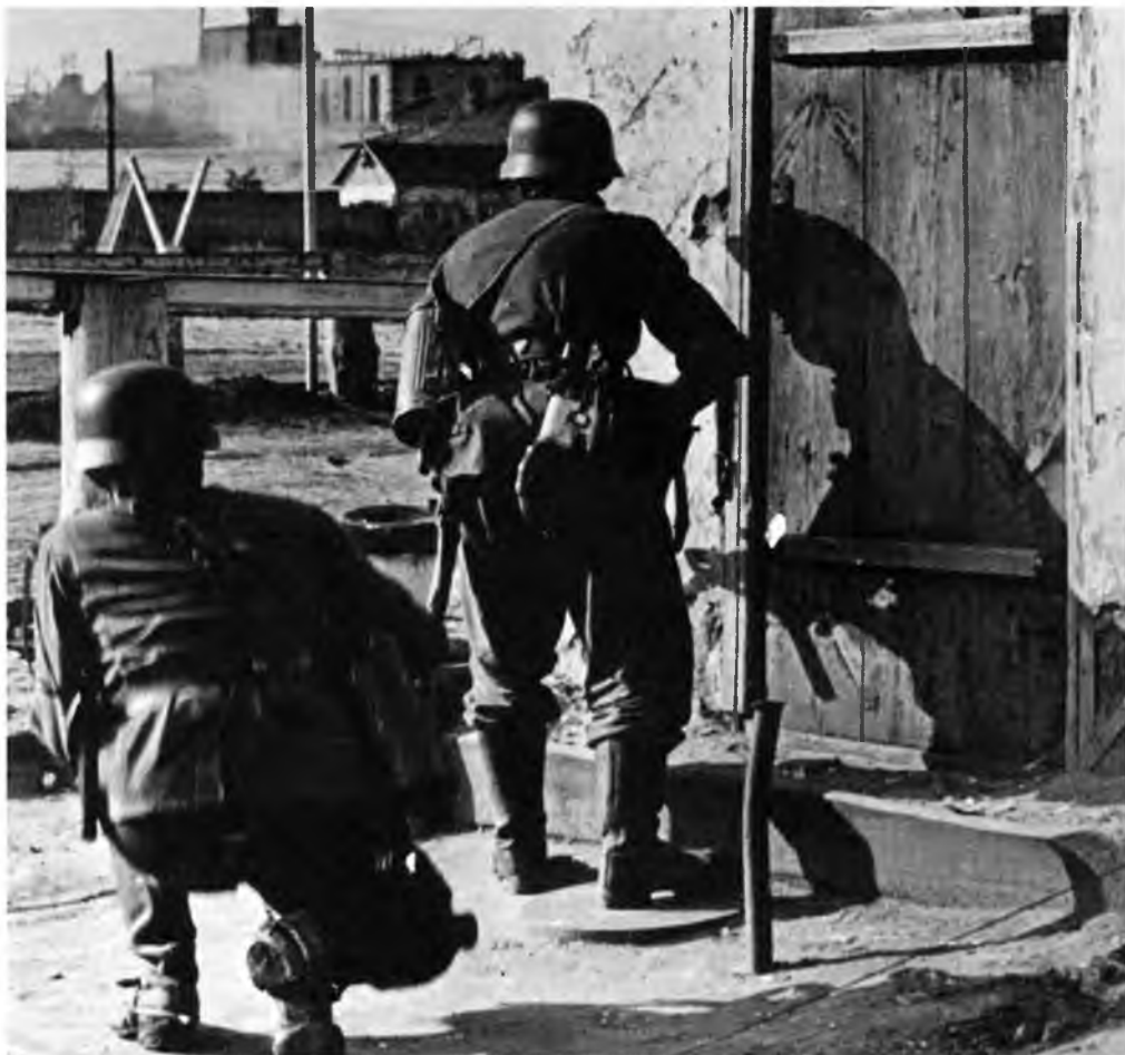
Пехотинцы вермахта штурмуют железнодорожную станцию. Украина, сентябрь 1941 года (РГАКФД).
