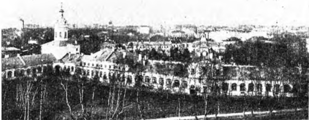
112. Сѣверо-Западная башня и Сѣверный корпусъ.
