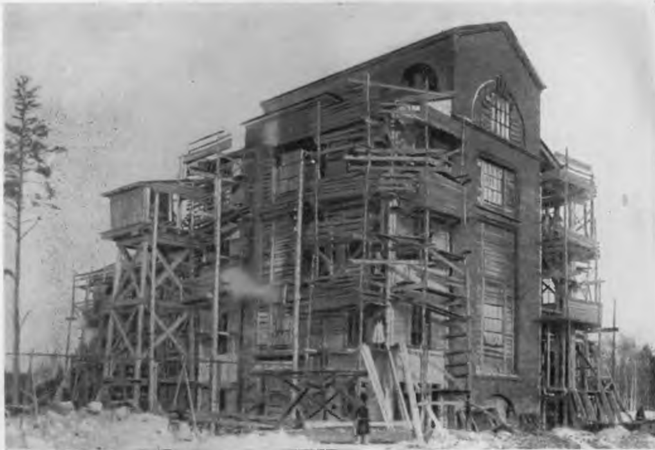
Строительство подстанции Шатурской ГЭС. 1920 г. (Фото.)
