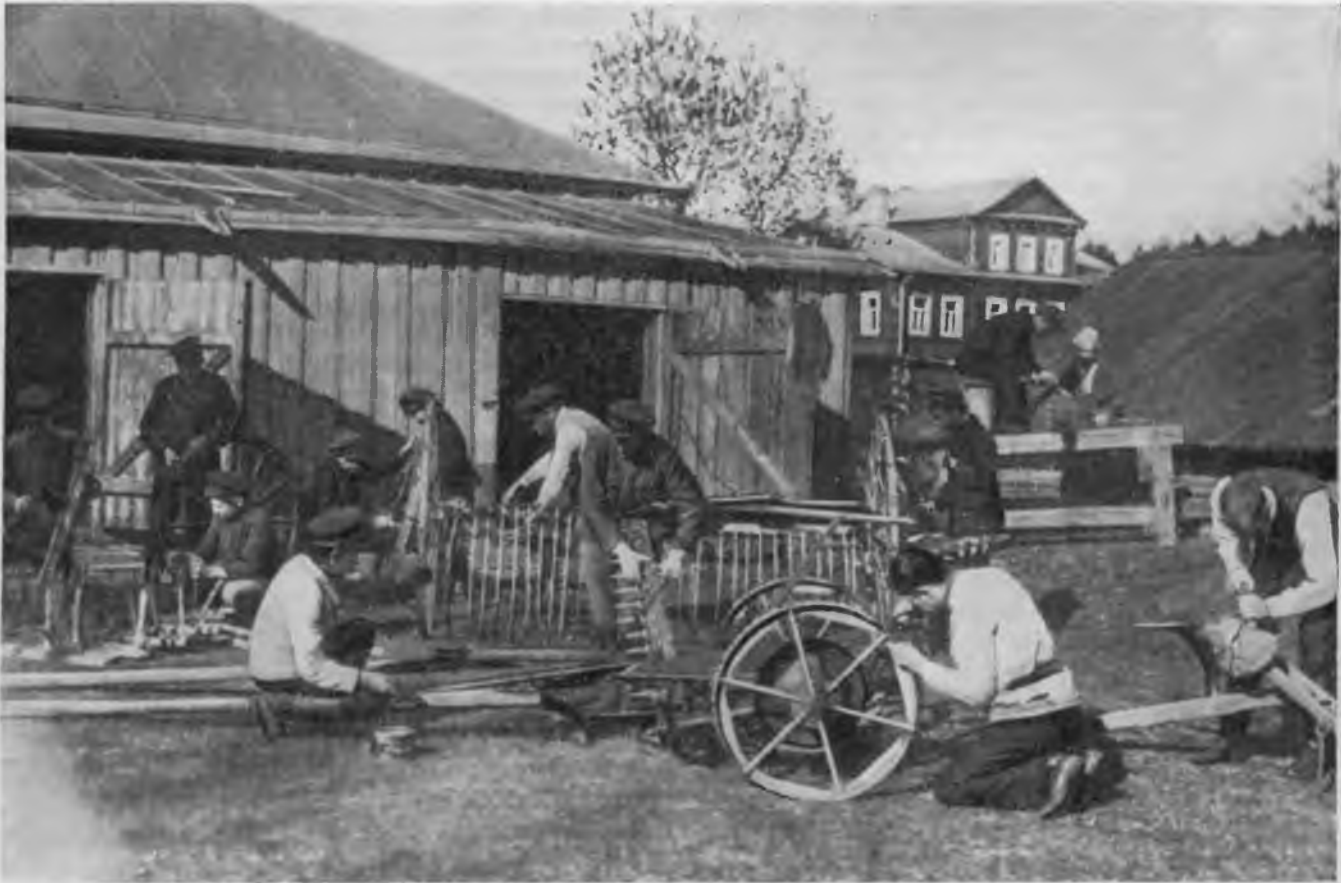
Городские рабочие помогают крестьянам ремонтировать сельскохозяйственные орудия. Август 1920 г. (Фото.)
