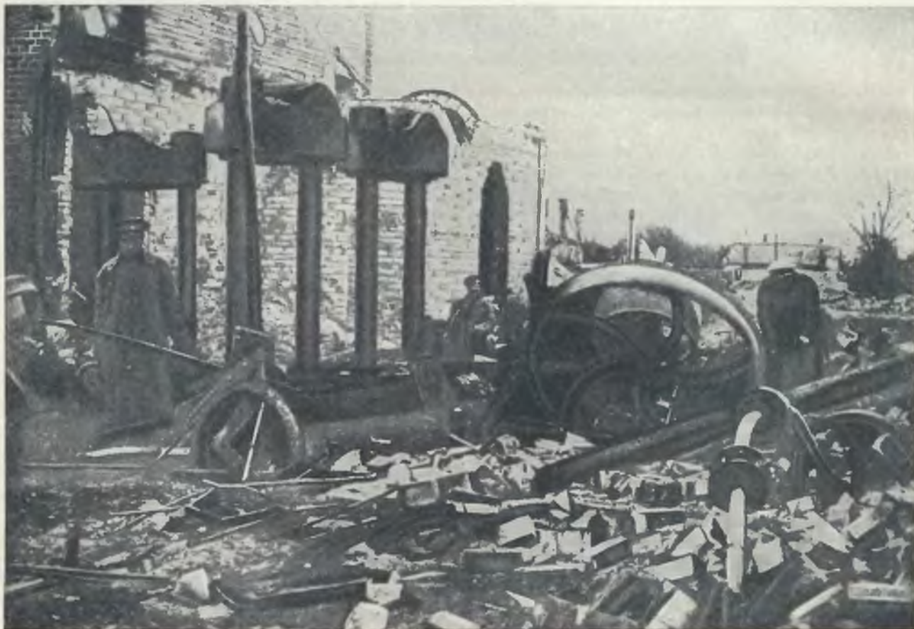
В прифронтовой полосе. Разрушенные фабрики.
