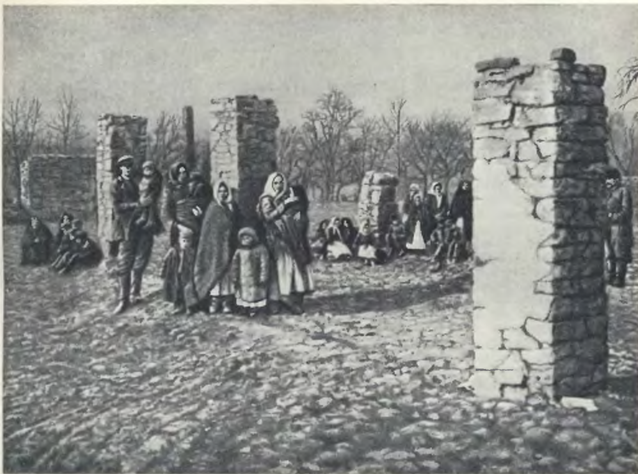
В прифронтовой полосе. Разрушенные села.
