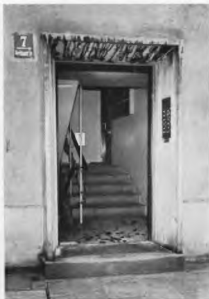
Вхідні двері до будинку ч. 7 при вул. Кройтмайра
