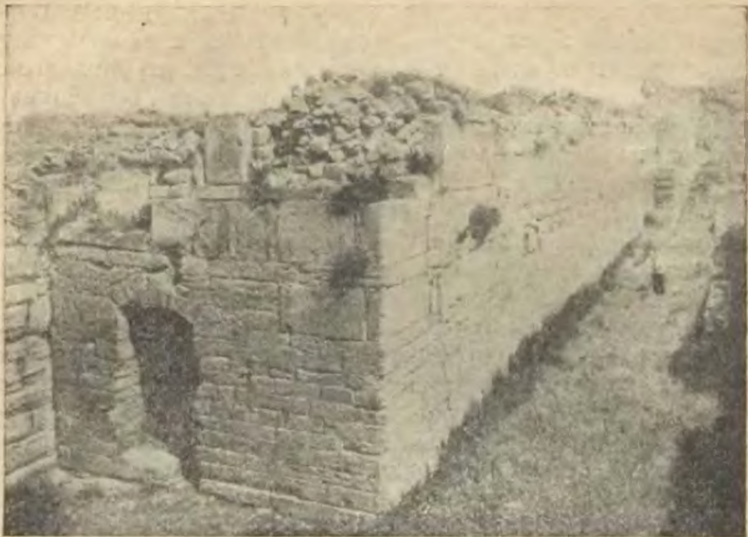
Херсон. Крепостные стены. Юго-восточный участок. Верхний ярус. V—VI вв.
